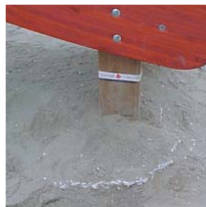
Pericolo connesso a cemento esposto.
